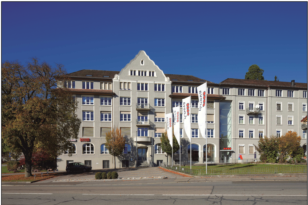
Gewerbeliegenschaft ri.nova, Alte Landstrasse 106, Rebstein
